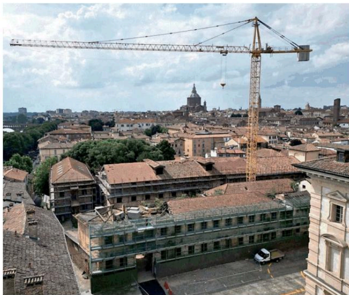
Il complesso di piazza Borromeo sovrastato dalla grande gru del cantiere
